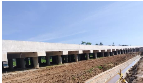
Gambar 7. Jembatan Pile Slab Sumber : Dokumentasi pribadi
