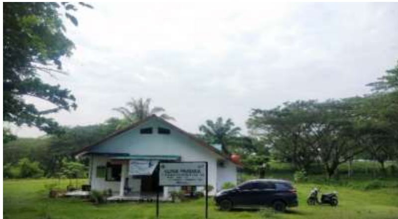
Gambar 7. Puskesmas Sumber: Dokumentasi Lapangan, 2023.
