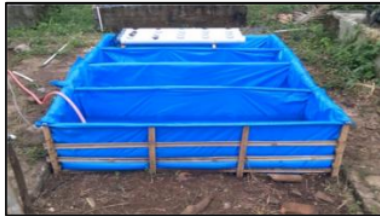
Pemasangan Instalasi Akuaponik
