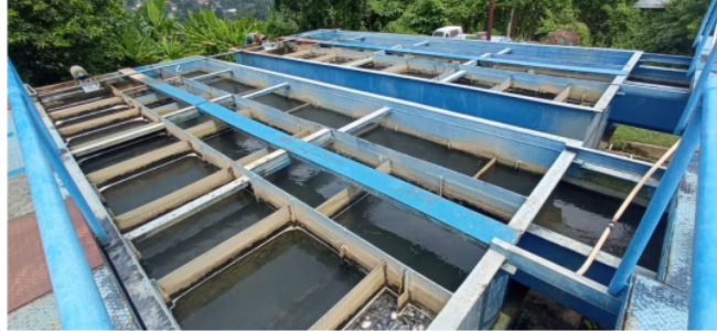
Gambar 6. Bak flokulasi
