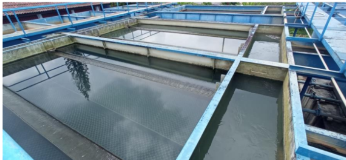
Gambar 7. Bak sedimentasi
