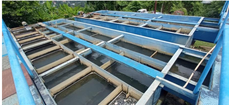
Gambar 6. Bak flokulasi
