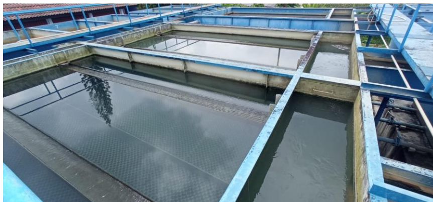
Gambar 7. Bak sedimentasi
