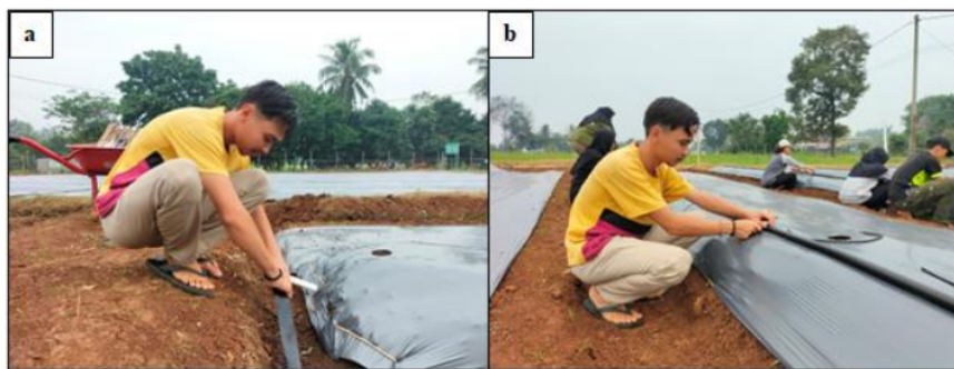
Gambar 9. Pemasangan pengairan. a) pemasangan selang PE. b) pemasangan drip tetes.
