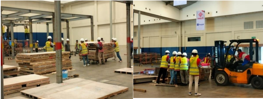
Gambar 1. Monitoring Progres Pekerjaan Oleh Site Supervisor
