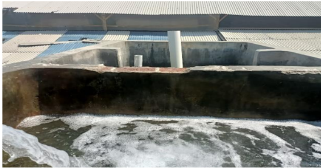
Gambar 5. Transfer Air Laut ke Sandfilter (Sumber : Dokumentasi Pribadi)
