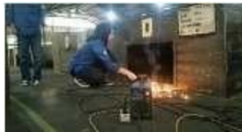
Gambar 14. Perbaikan pintu withering trough (Sumber: Dokumentasi pribadi, 2023)
