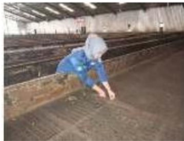
Gambar 16. Perbaikan fishing net withering trough (Sumber: Dokumentasi pribadi, 2023)
