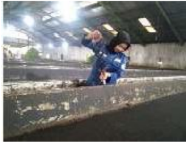
Gambar 15. Perbaikan dinding withering trough (Sumber: Dokumentasi pribadi, 2023)
