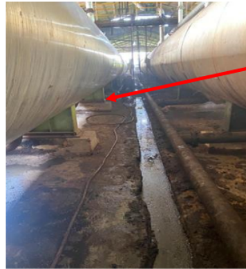
Gambar 17. Pondasi (kaki perebusan) (Sumber: Dokumentasi pribadi, 2023)
