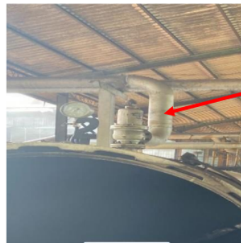
Gambar 15. Safety valve (Sumber: Dokumentasi pribadi, 2023)
