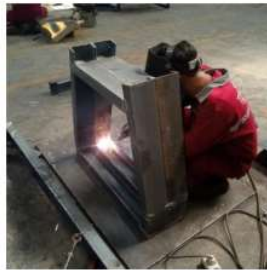
Gambar 17. Perakitan konstruksi rangka
