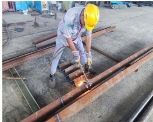
Gambar 7. Proses pemotongan besi siku dan pipa menggunakan mesin las asitelin
