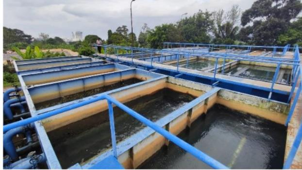
Gambar 8. Bak Filtrasi
