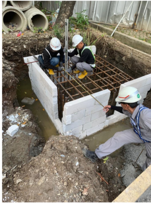
Lampran 6. Penempatan posisi pile cape
