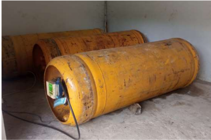
Gambar 9. Tabung gas Khlor Sumber: Dokumentasi lapangan di Perumda AM Way Rilau
