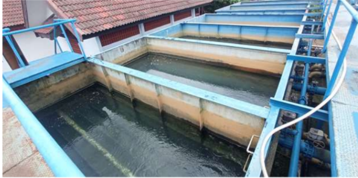
Gambar 8. Bak Filtrasi
