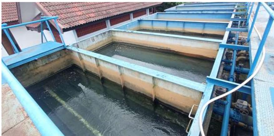
Gambar 8. Bak Filtrasi
