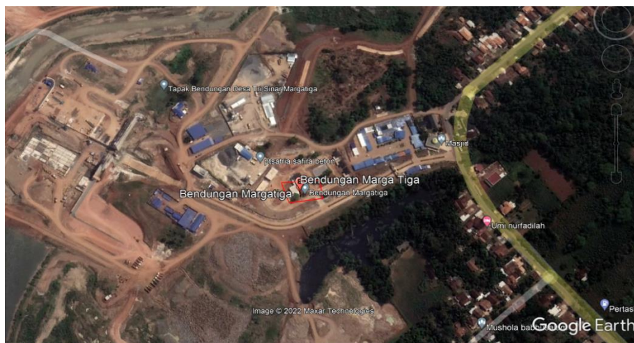
Gambar 1.1 Lokasi Proyek Bendungan Margatiga
