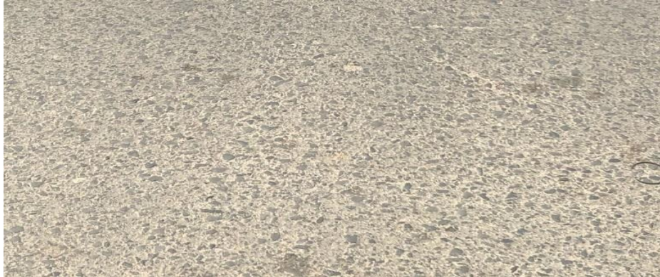
Gambar 2.9 Jenis Kerusakan Pengausan Agregat
