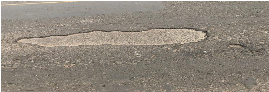
Gambar 2.5 Jenis Kerusakan pengelupasan lapis permukaan
