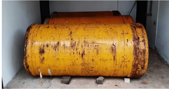
Gambar 1.10 Tabung Gas Khlur Sumber: Dokumentasi lapangan di PDAM Way Rialu
